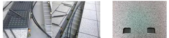
[그림 2] 케이블 배선 및 처리 방안
